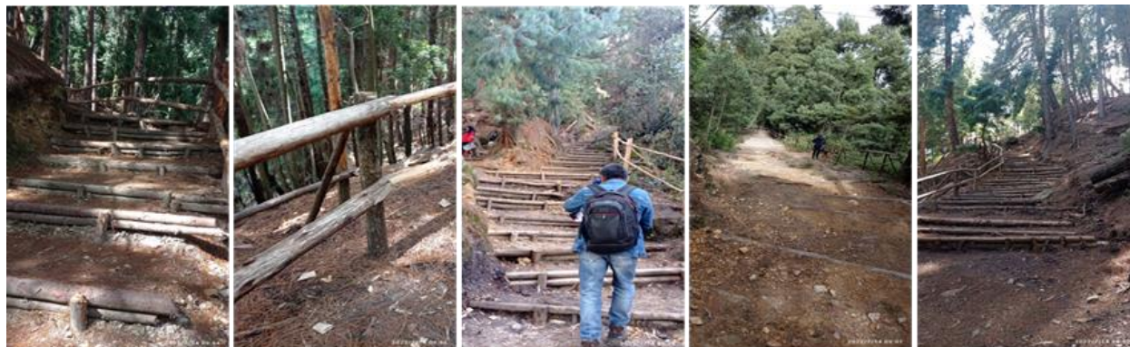
Adecuaciones camino Pico de Águila - Fuente: IDT
